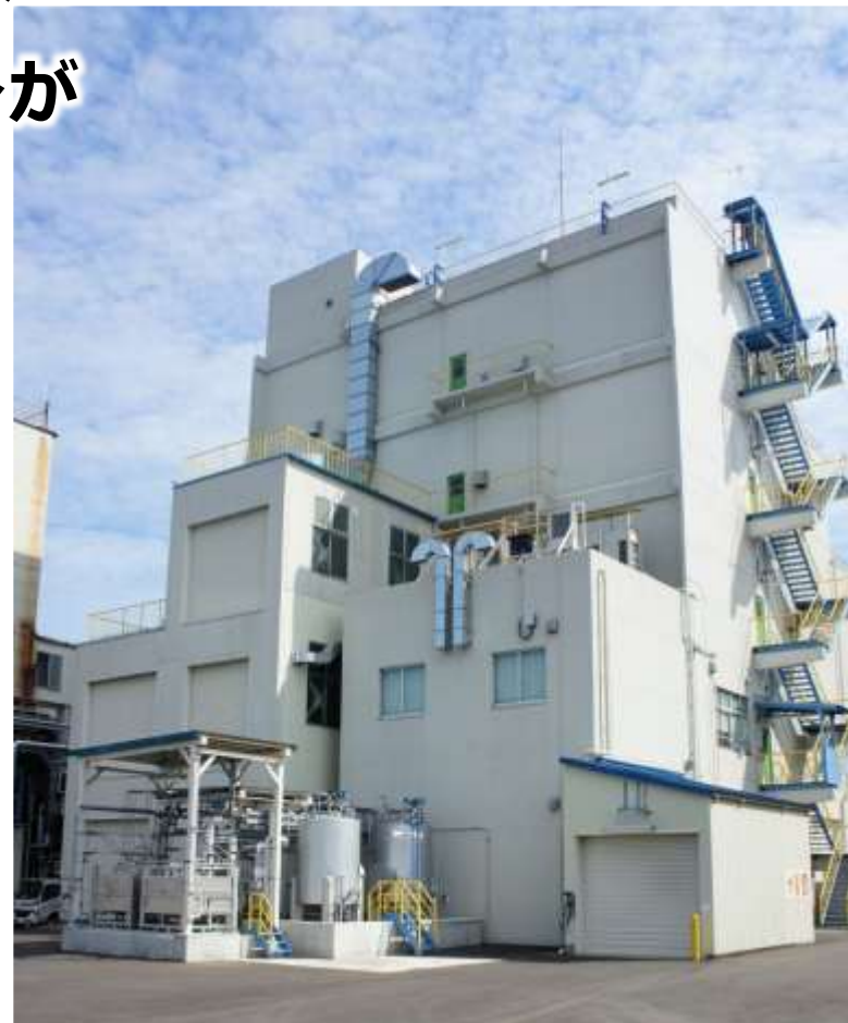
新井工場 機能化学品製造設備
