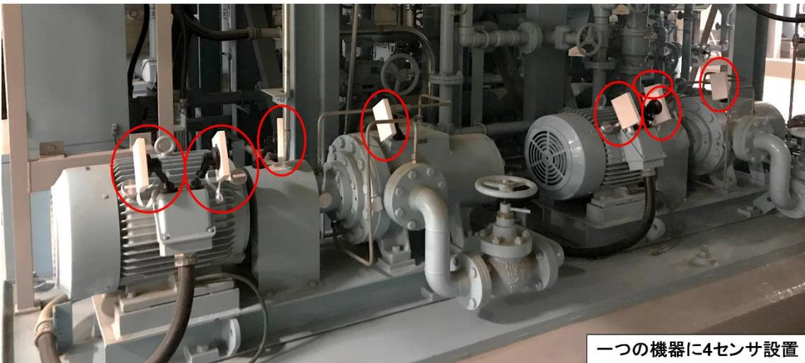
「高感度有機フィルム振動センサデバイス」は、東北電力株式会社、BIPROGY 株式会社が取組み「火力発電所における設備パトロール業務を、ロボットや AI 技術等により
